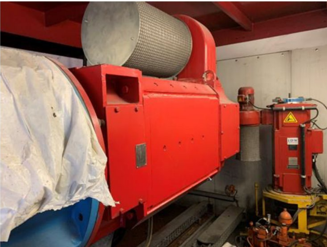
HOISTING MOTOR
